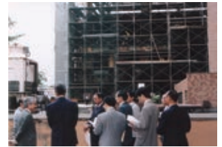
建築中の形質統御実験棟
