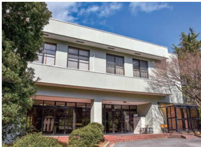
職員会館 外観
