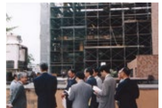
建築中の形質統御実験棟
