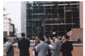
建築中の形質統御実験棟
