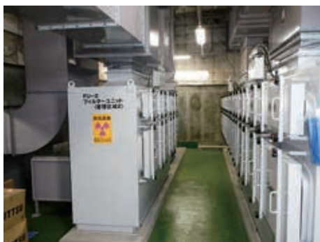
RI 排気設備
