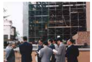
建築中の形質統御実験棟
