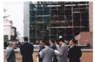
建築中の形質統御実験棟
