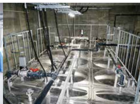
RI 排水設備
