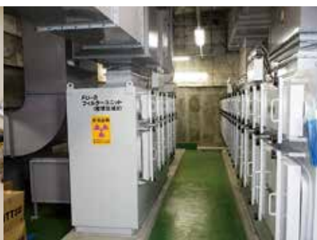
RI 排気設備
