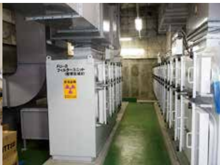
RI 排気設備
