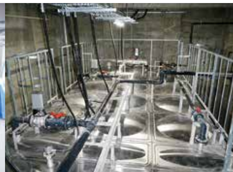
RI 排水設備
