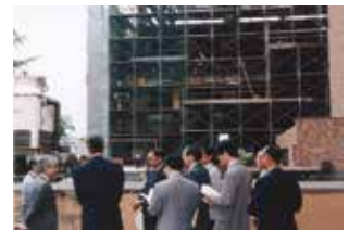
建築中の形質統御実験棟
