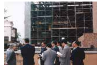
建築中の形質統御実験棟
