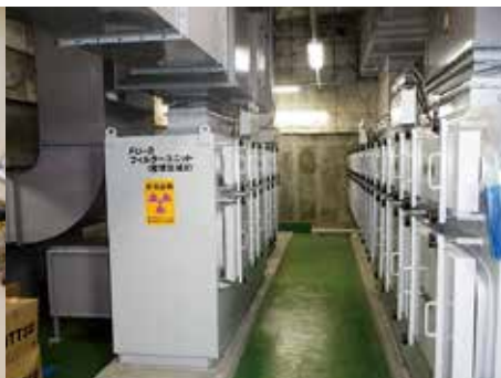
RI 排気設備
