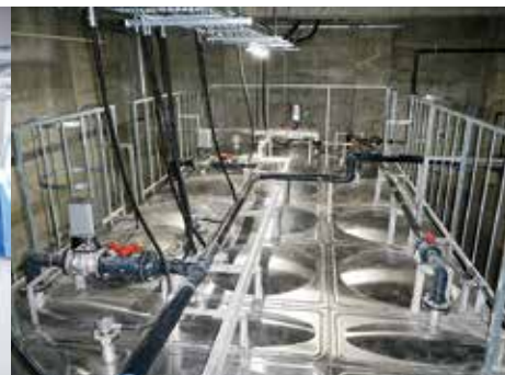
RI 排水設備
