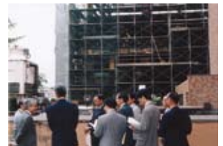
建築中の形質統御実験棟
