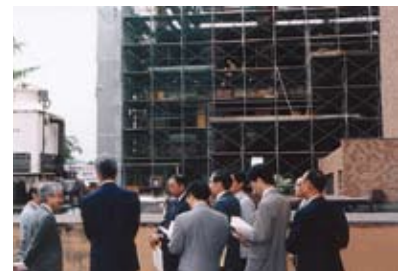
建築中の形質統御実験棟
