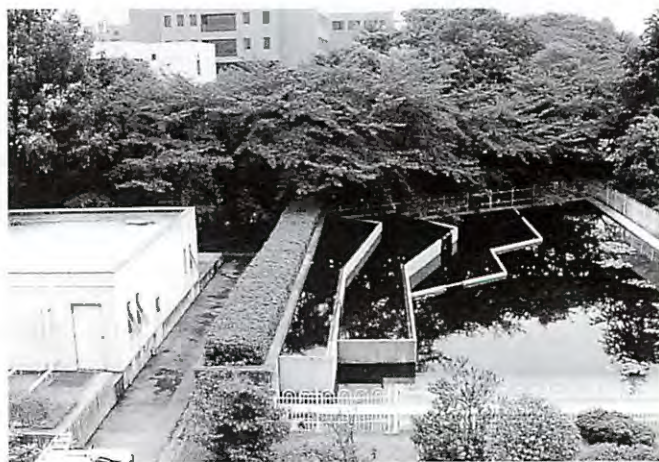
廃棄物処理室
