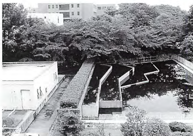
廃棄物処理室
