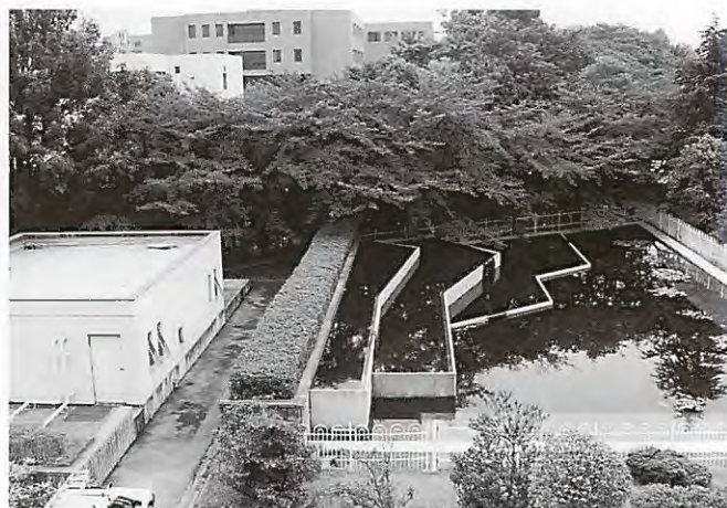
廃棄物処理室
