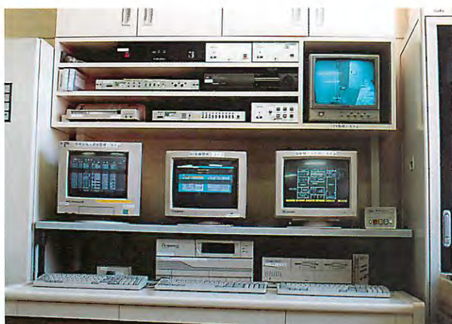
アイソトープセンターの総合監視システム
