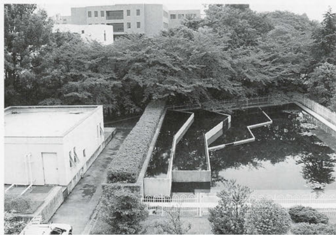
廃棄物処理室
