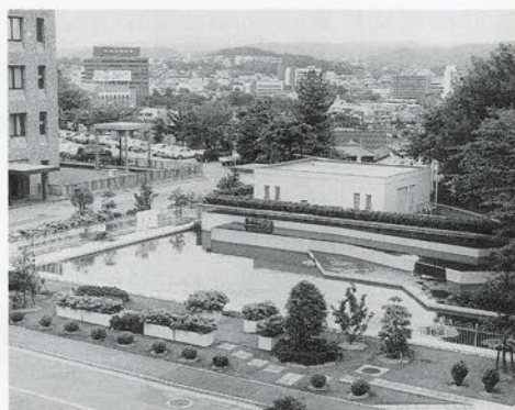
実験廃水処理施設
