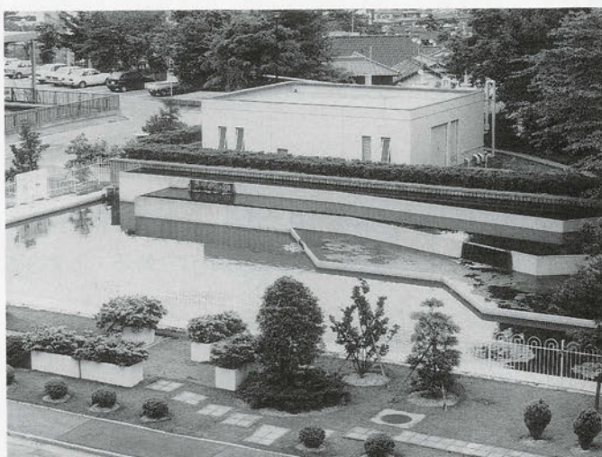
実験廃水処理施設
