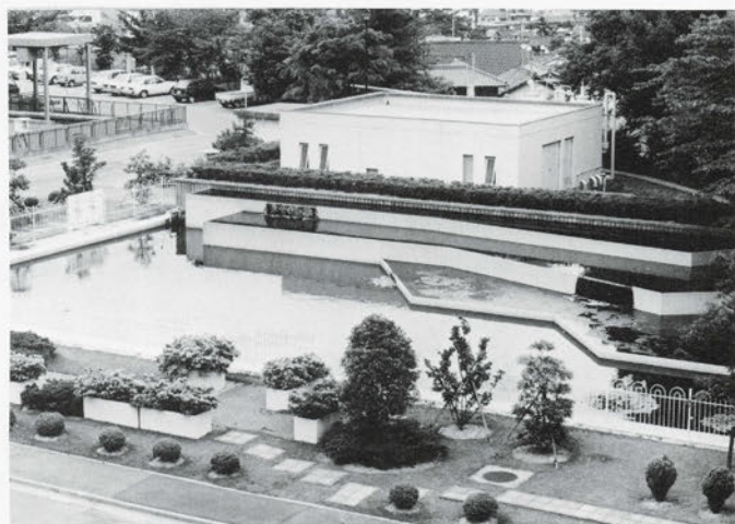
実験廃水処理施設
