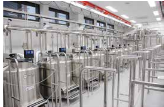
IBBPセンター内の液体窒素による生物遺伝資源超低温保存システム
