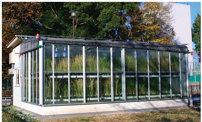
2005 年度設置した P1 温室
