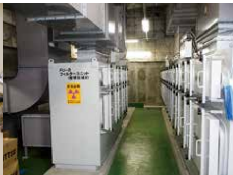
RI 排気設備
