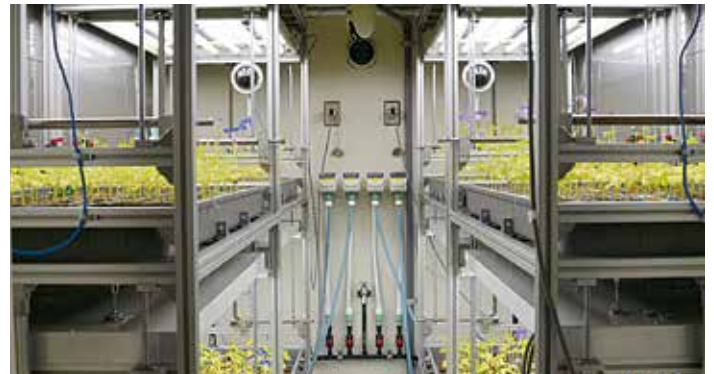
植物環境制御システム
