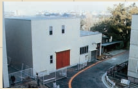
外装が完成したMRI室
