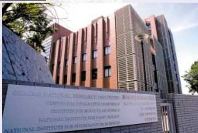
2003年に完成した山手地区の実験棟
